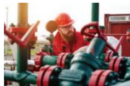
Rurociągi przedsiębiorstw naftowych i gazowych
